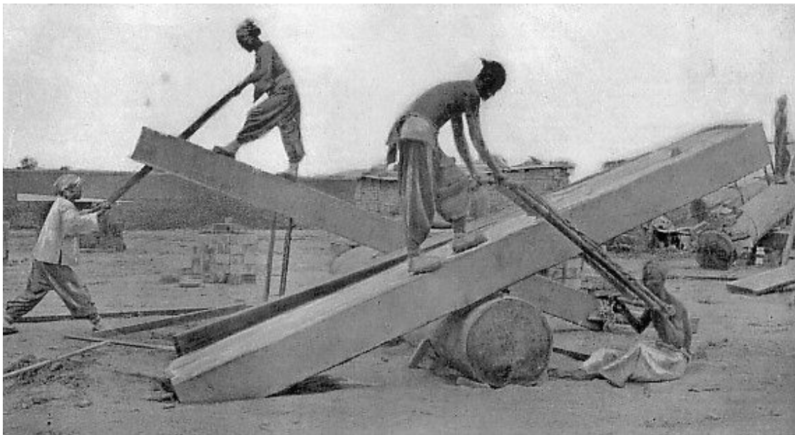
Charpentiers chinois sciant du bois de construction
